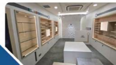
港鐵金鐘站失物辦事處 室內翻新工程
