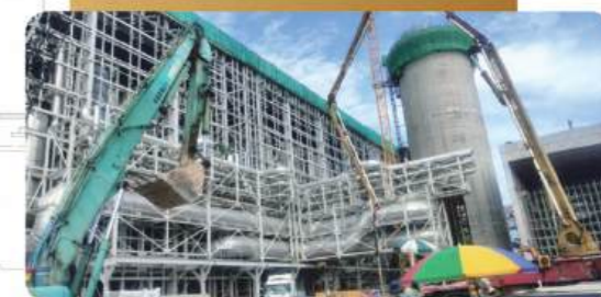
石鼓洲焚化爐預製機電組件電力工程
