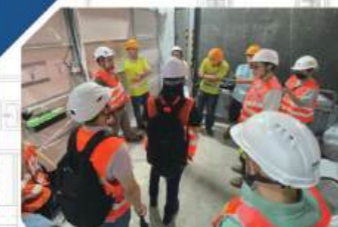
港鐵觀塘站室內裝修工程
