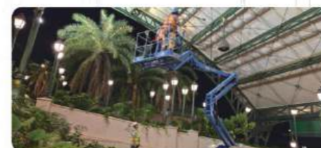
港鐵迪士尼站(第一期) 金屬設施翻新工程
